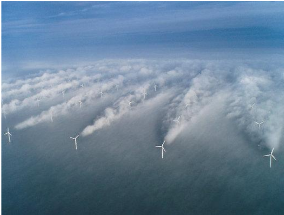
Fig. 4 : Les turbulences induites par le mouvement des pales – mortelles pour les chauves-souris - sont imperceptible à l'œil nu, sauf lorsque l'air est saturé en humidité (source de l'image : http://eolienne.f4jr.org/sillage ).
