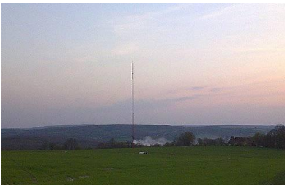
Fig. 14 : Mât de mesures de vent (Chevaize – France) sur lequel est installé un système de détection à ultrasons.
